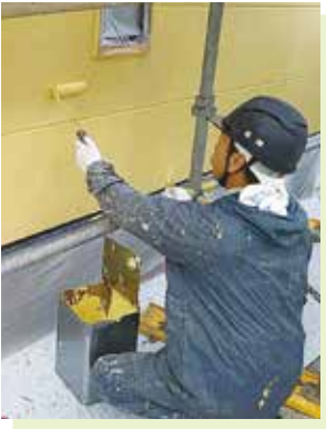
外壁の中塗り
